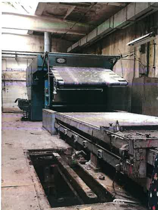
Mașinărie specifică + detaliu pardosea, prima travee, sursă arhive personale Dumescu Diana, 2023
