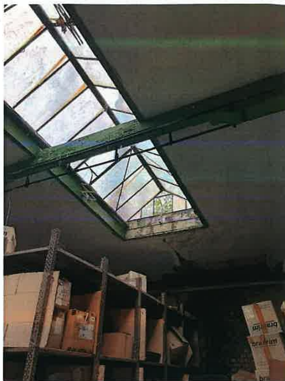
Detaliu grindă de lemn și luminator, sursă arhive personale Dumescu Diana, 2023
